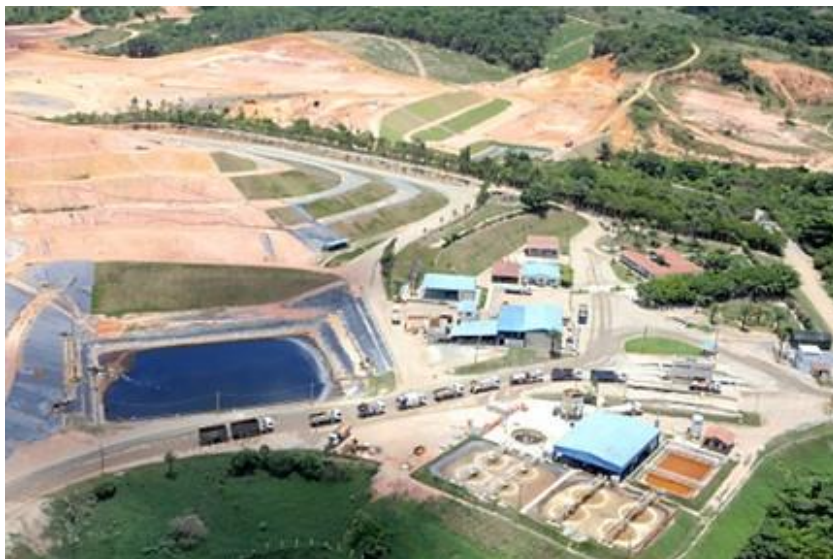
Imagem 02 - Aterro Sanitário Orizon Jaboatão dos Guararapes
